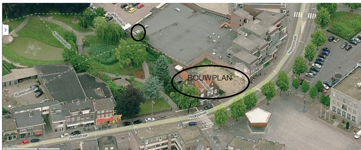
Figuur 4. 1: Locatie van de condensor op het dak van de Aldi supermarkt (Bron: Bing Maps)
