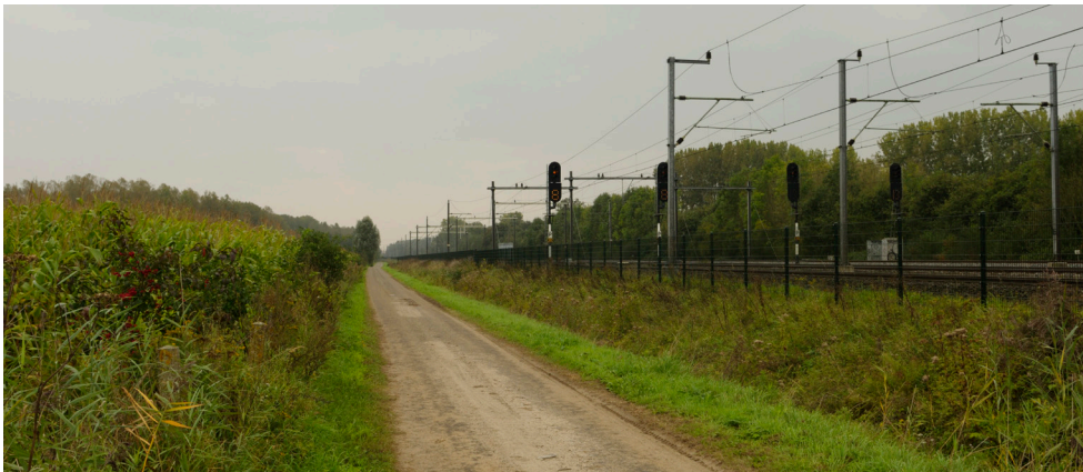
04 - pad langs spoor naar zendmast. op maisakker is het aanlooptalud gepland
