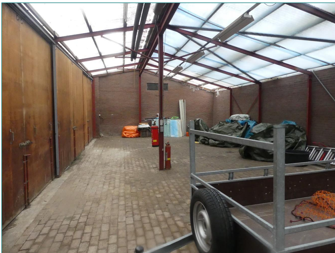
Figuur 4 Opslag op de binnenplein aan de Heilig Hartstraat.
