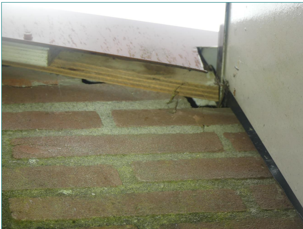
Figuur 3.2 Opening aan de zuidzijde van Heilig Hartstraat 10 met toegang tot de spouwmuur.
