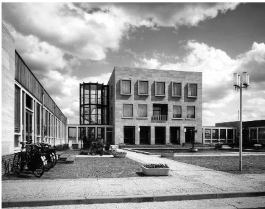
Het gemeentehuis vanaf de achterplaats kort na de bouw. Archief De Bever Architecten.
