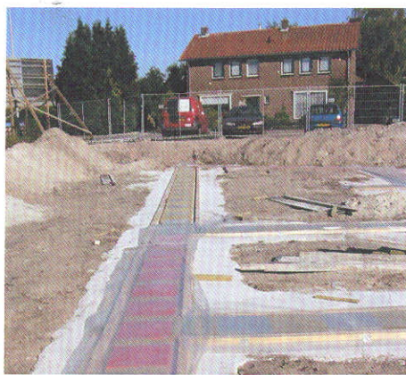
De trillingisolierende matten op de sloof (rood). Tussen de matten het steenwol.
