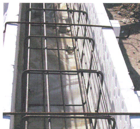
Bekisting en wapening in de funderingsbalk. De PS bekisting dient tegelijkertijd als trillingisolator.
