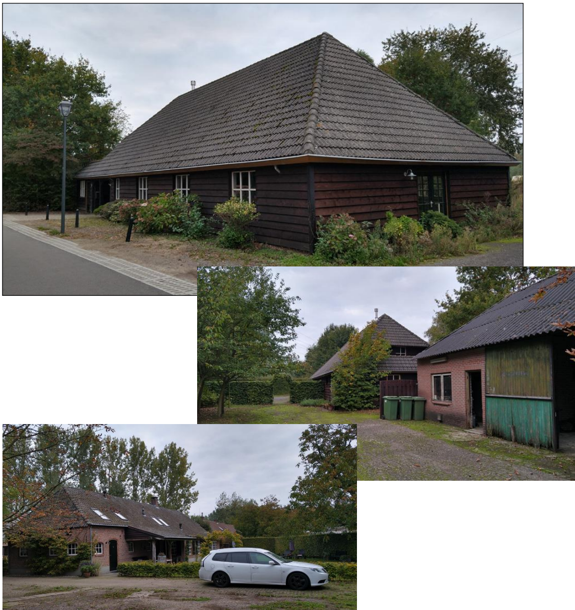
Figuur 4: Enkele foto's van het veldbezoek: het voormalige museum vanaf de Broekdijk nr 12, zicht terug naar het museumgebouw langs het kleine bijgebouw nr 14 en de achterzijde van nr 16 waar tot 2014 de klompenfabriek stond.
