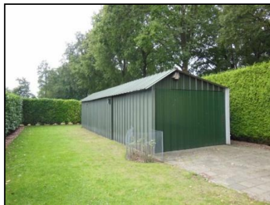
Figuur 7. Loods noordwestelijk deel van de projectlocatie.
