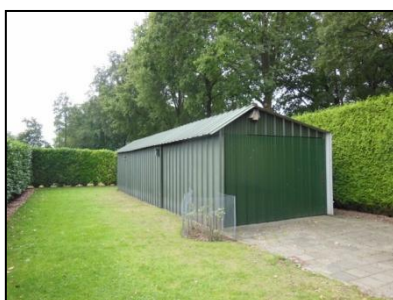
Figuur 7. Loods noordwestelijk deel van de onderzoekslocatie.
