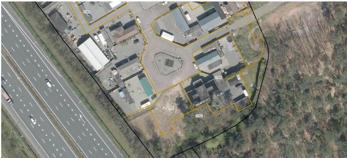
Bestaande situatie ter plaatse van de standplaatsen waar deze herziening betrekking op heeft
