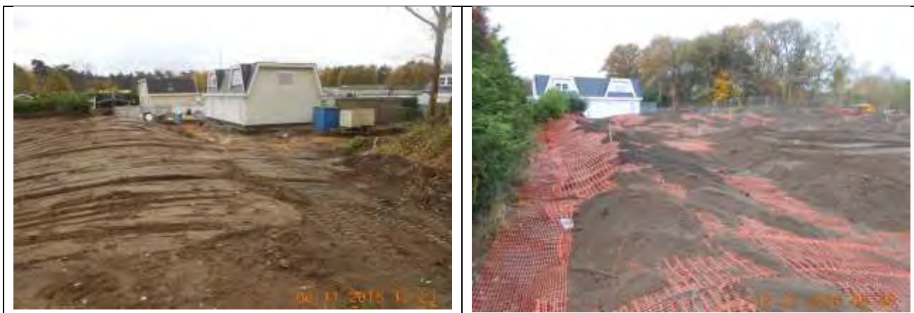
Figuur 2.3: Foto's grondsanering 2015
