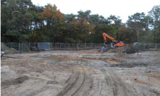
Figuur 3.1: Foto's ontgravingswerkzaamheden
