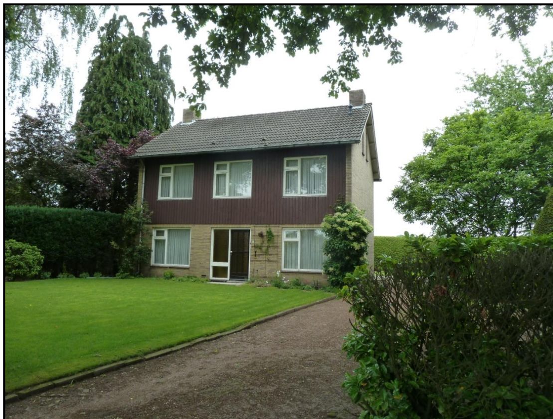
Figuur 1. Te slopen woonhuis Sonseweg 13.
