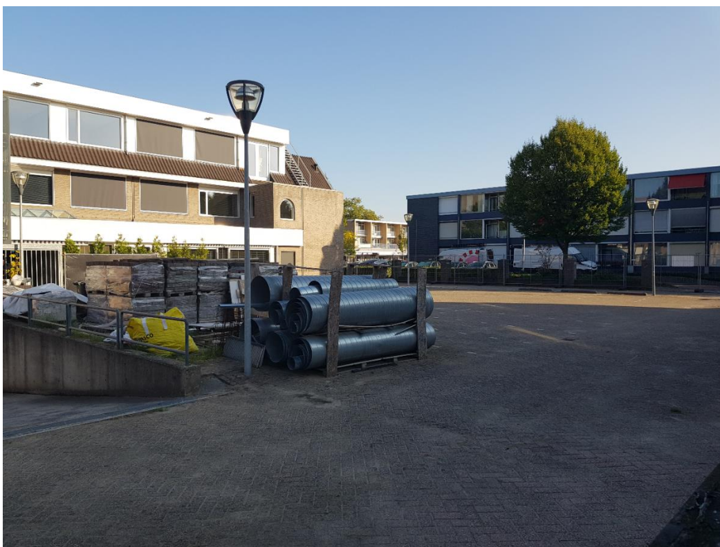
Figuur 1.2: foto huidige situatie
