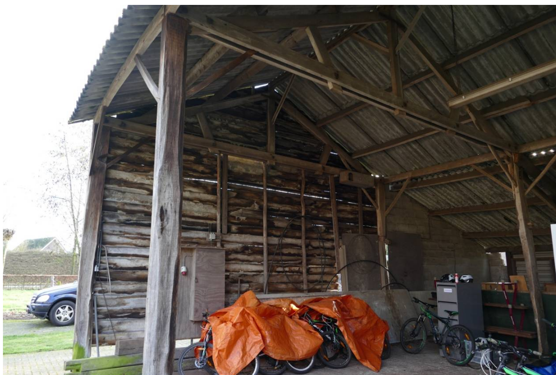
Figuur 8 Interieur met eiken staanders en kap van gezaagd vurenhout.
