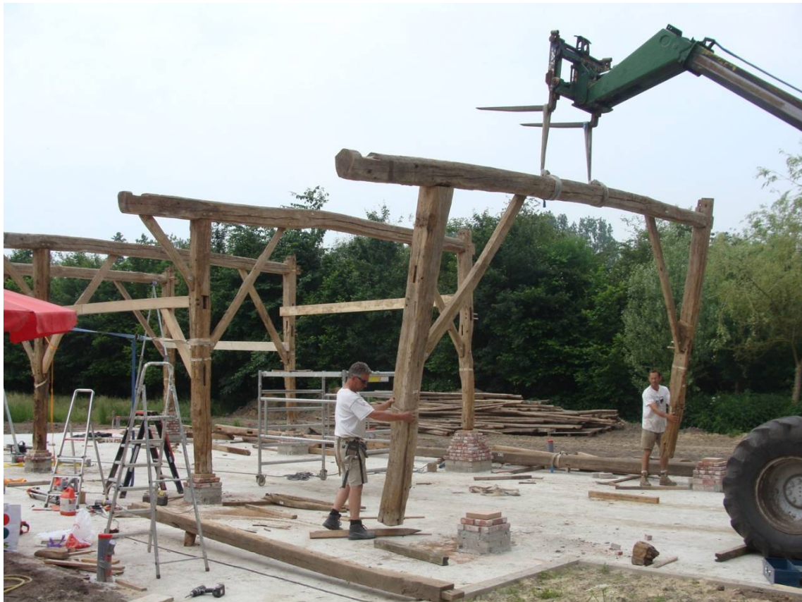
Voorbeeld van een herplaatsing van een oude schuur in Olland met gebruikmaking van oude gebinten.
