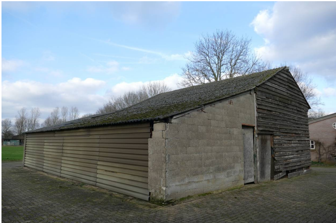
Figuur 5 De veldschuur heeft een vrij forse aanbouw met een knik in de daklijn. Waarschijnlijk is ook de achtergevel oorspronkelijk opgetrokken geweest in betonsteen.
