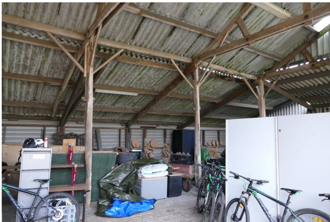
Figuur 7 Het interieur is thans een onverdeelde ruimte.
