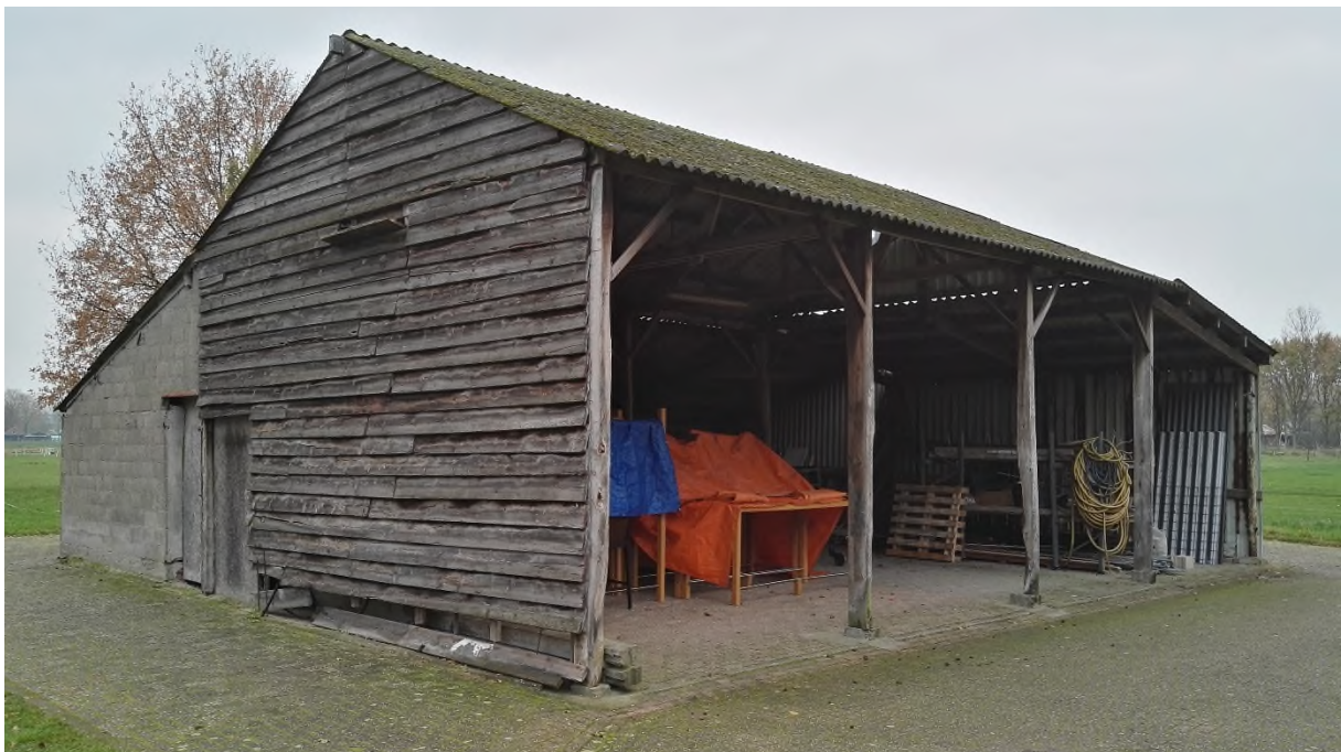
Figuur 9: De schuur binnen het oostelijke deel van het plangebied.
