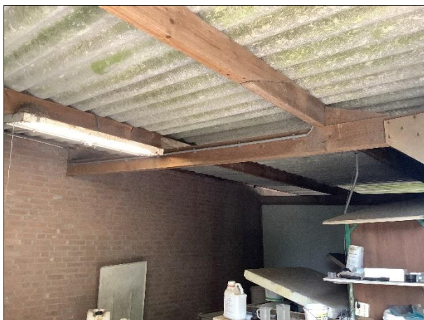
Foto 7 Vogelnest op de armatuur van een lamp in de oostelijke bedrijfsloods
