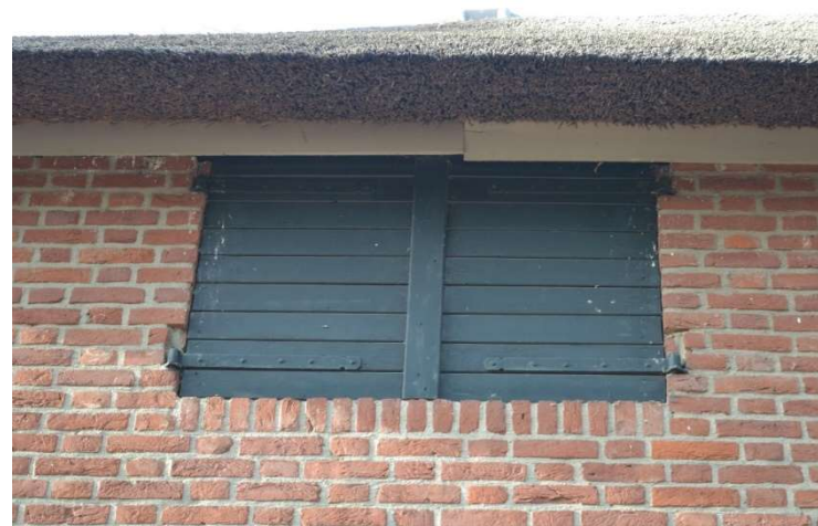
Dubbele houten luiken op verdieping.
