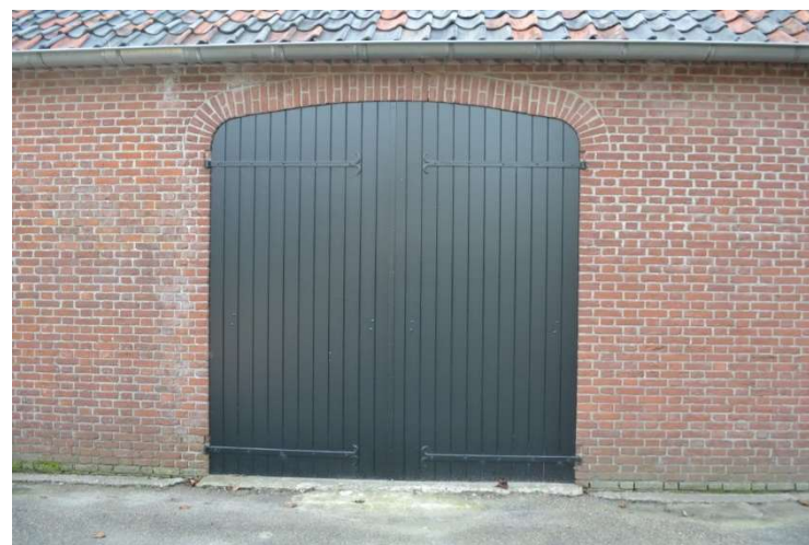
Nieuwe deeldeuren onder segmentboog.
