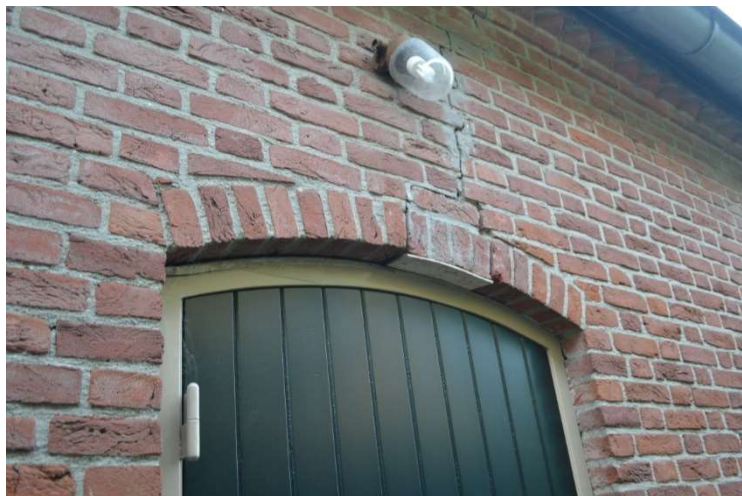
Nieuw aangebrachte loopdeur in houten kozijn.
