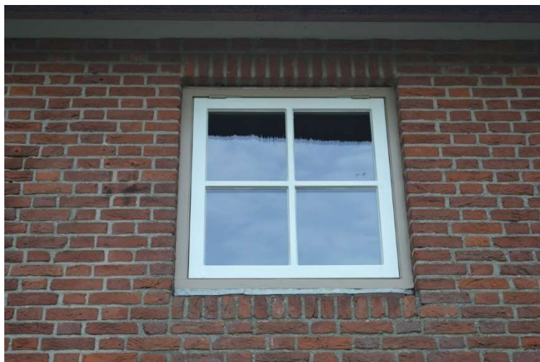
Vernieuwd venster op verdieping.
