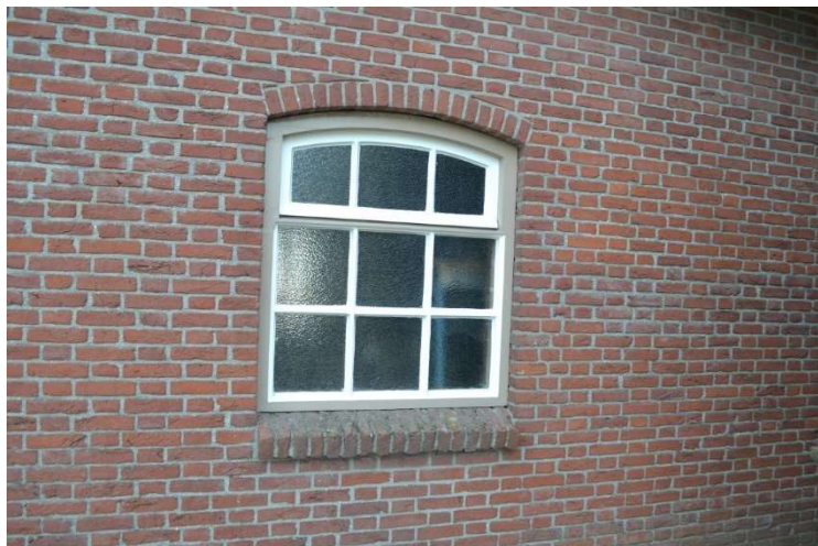
Nieuw aangebracht houten kozijn in bedrijfsdeel.
