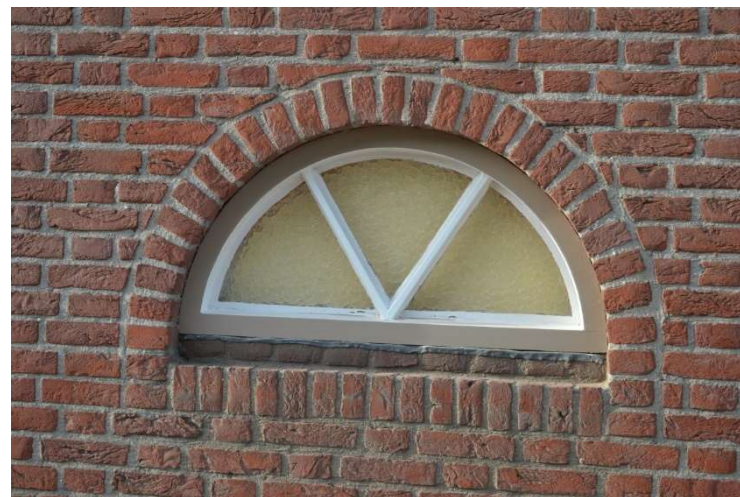
Halfrond rondboogvenster met houten kozijn.
