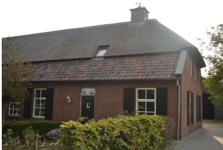
Woongedeelte van de langgevelboerderij.
