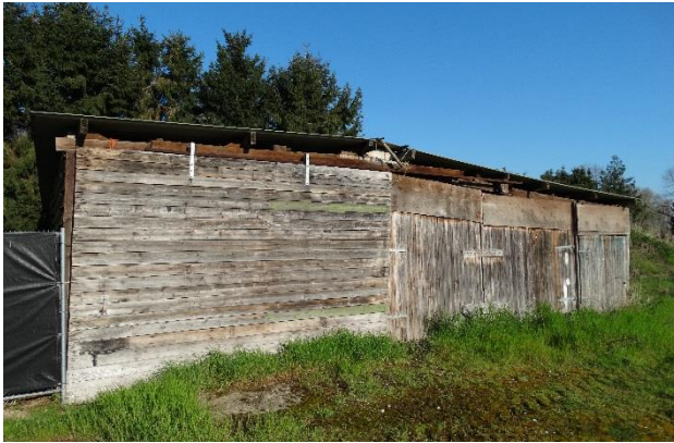
Figuur 9: Het te slopen houten schuurtje
