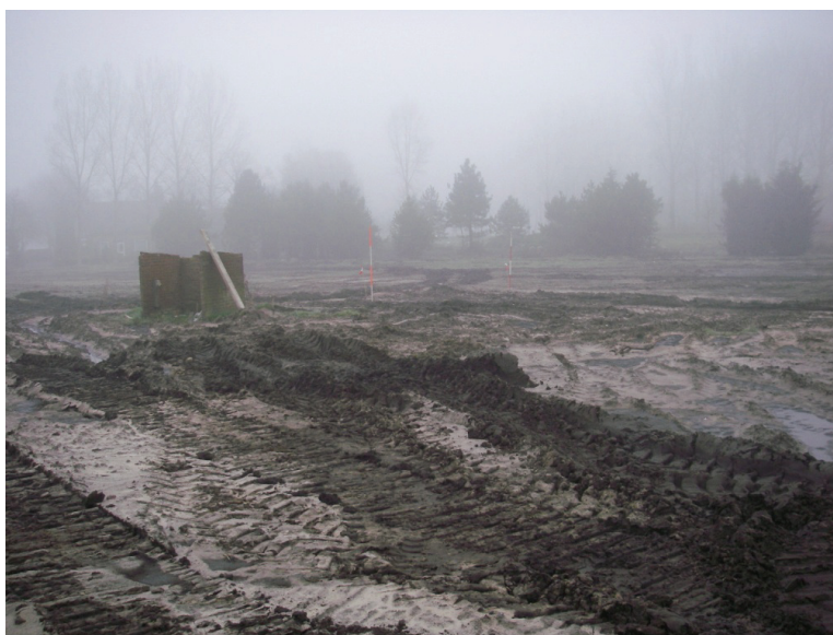
Fig. 1.2: Het plangebied bij aanvang van de werkzaamheden.
