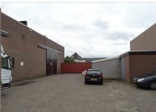
Figuur 8: Aanzicht magazijnen en stenen schuren voor opslag
