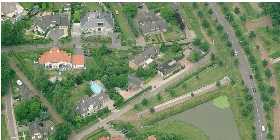
Luchtfoto bestaande situatie (bron: bingmaps.com)
