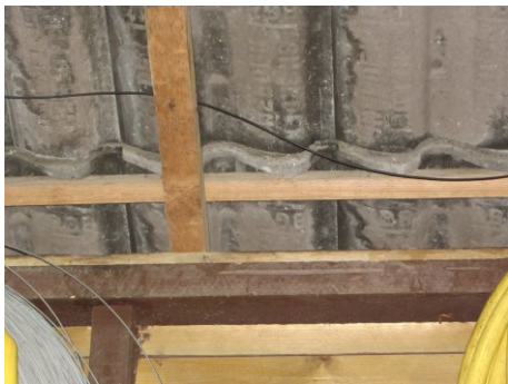
Figuur 9. Het dak bestaat uit een enkele laag dakpannen.
