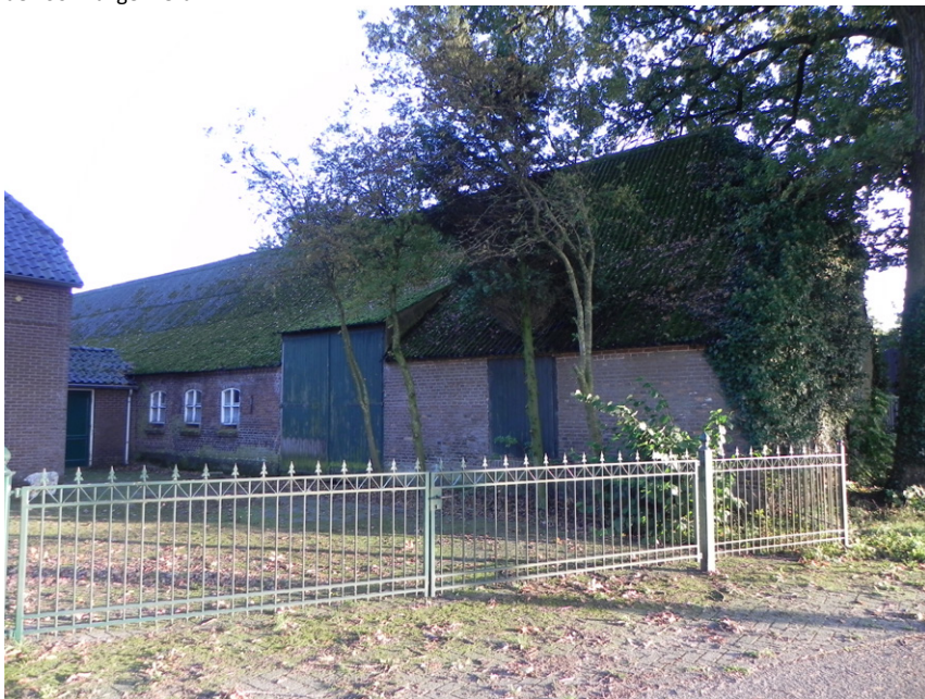
Best Burgstraat 7, voorzijde van het voormalige woongedeelte waarin nieuwe deeldeuren en dichtgetimmerd schuifvenster.
