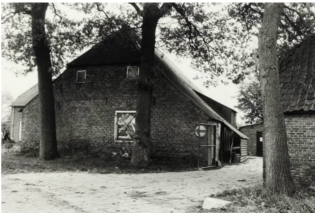
Westgevel ca. 1981. Beeldbank BHIC
