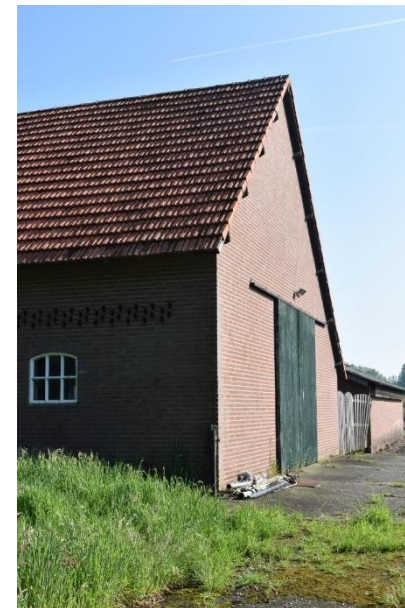
Rechterzijgevel vanaf voorgevel.
