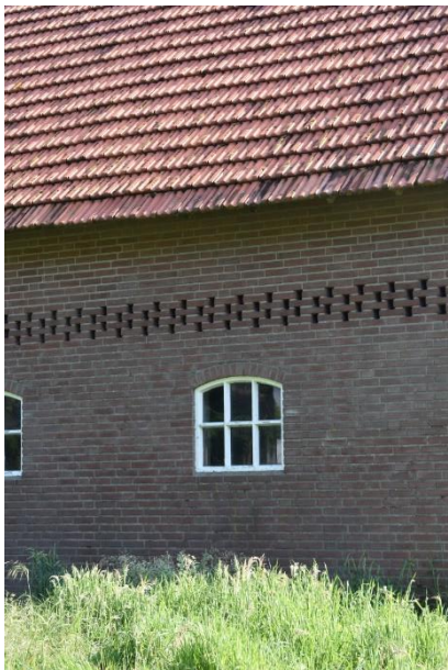
Betonvenster en ventilatiesparingen.
