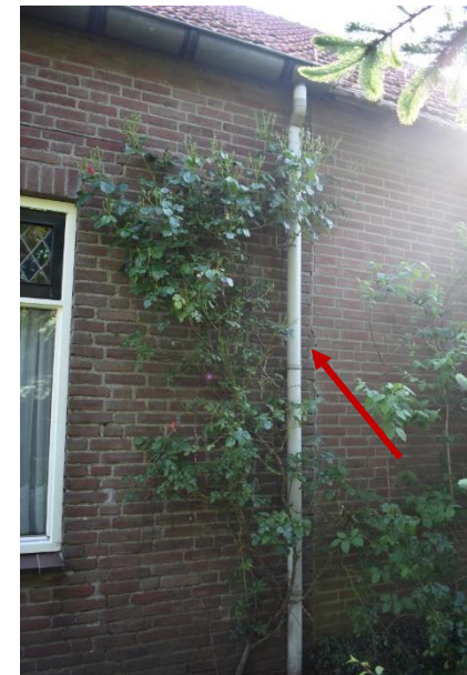
Aanheling nieuw metselwerk bedrijfsdeel.
