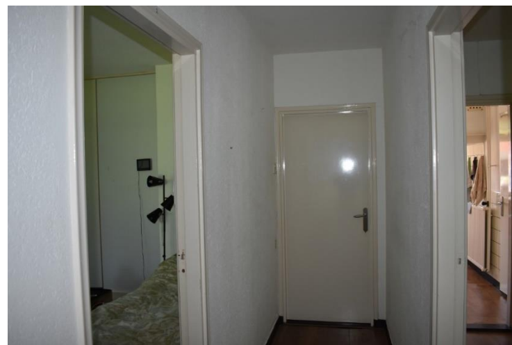
Gang met oorspronkelijke indeling en deuren.
