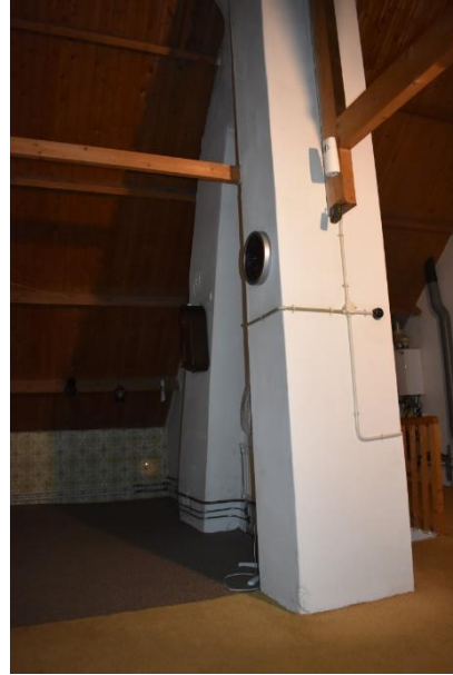
De kapconstructie en schoorsteenkanelen uit de bouwtijd.
