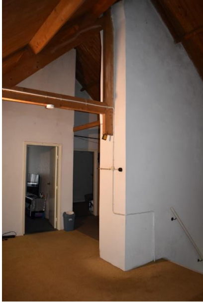
De kapconstructie en schoorsteenkanelen uit de bouwtijd.
