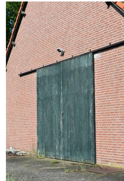
Dubbele schuifdeur aan rails.
