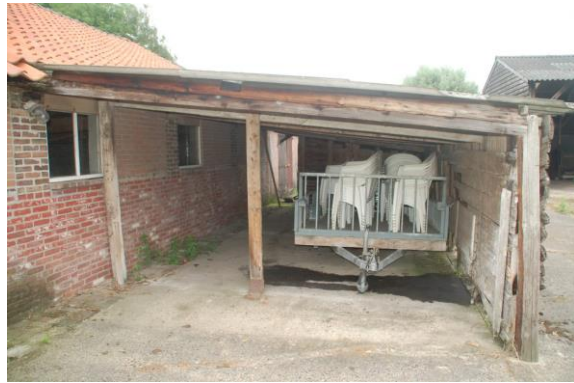
Overkapping achterzijde stal (5)
