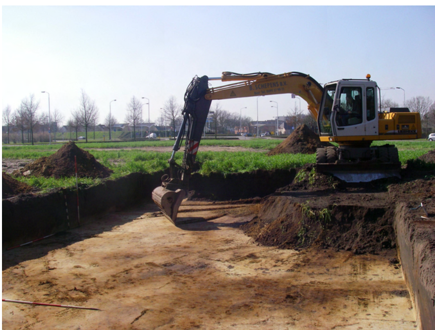
Fig. 6.2: Aanleg van het vlak in werkput 77
