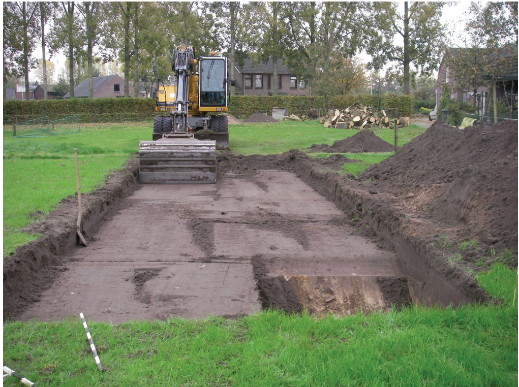
Fig. 4.1: Het verwijderen van de bovengrond in werkput 13 (locatie 4).
