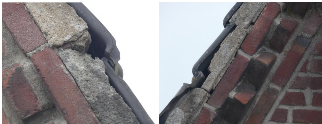
Figuur 4.3. Impressie toegang voor gierzwaluwen tot ruimtes onder het dak.
