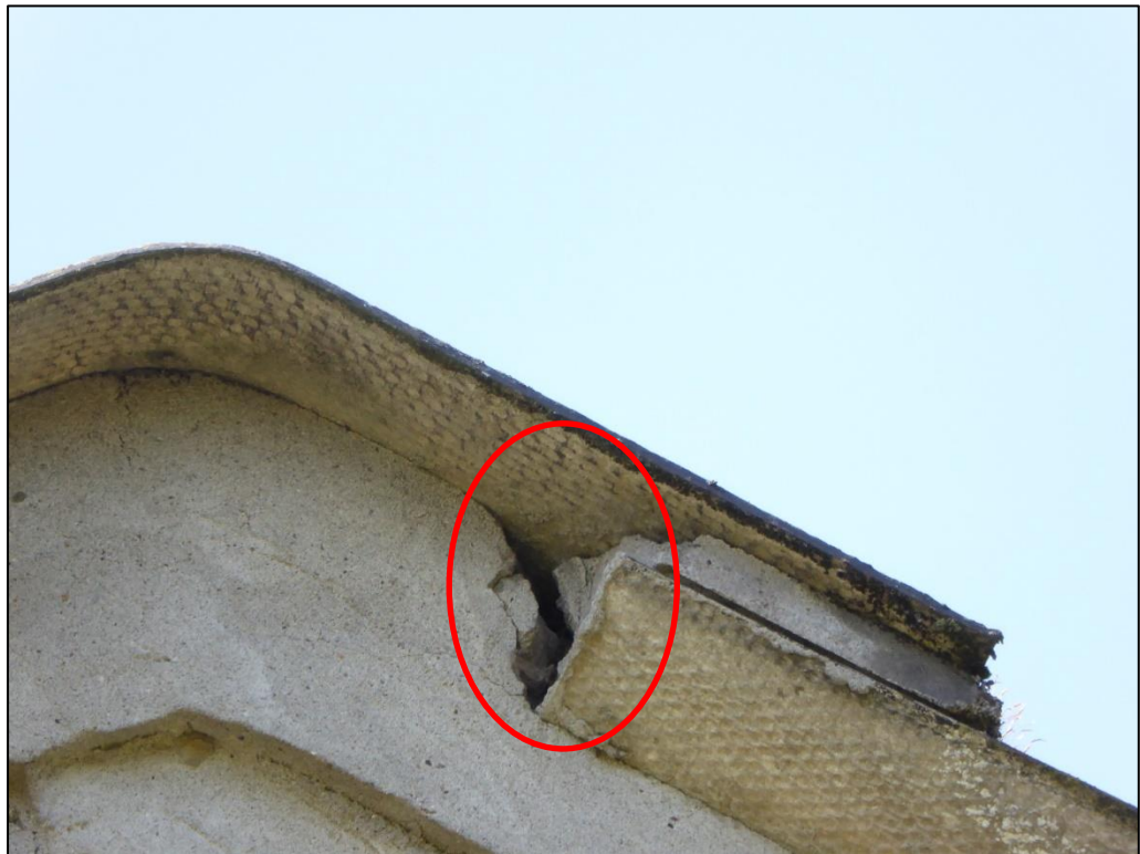
Geschikte kier voor vleermuizen bij de schuur die gesloopt gaat worden.
