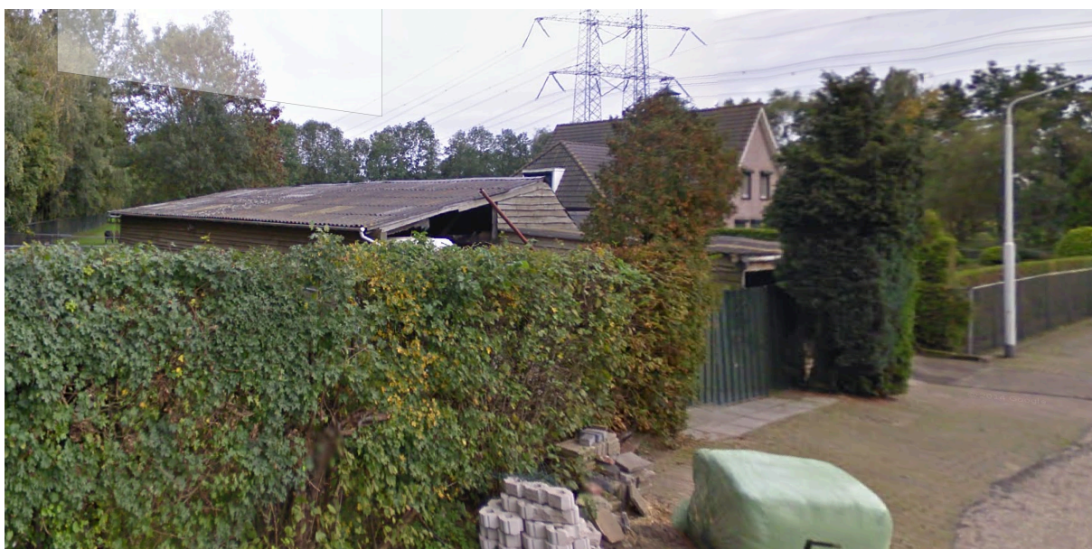
Afbeelding 5 Zicht op de loodsen van het perceel Kruisbeemdenweg 16
