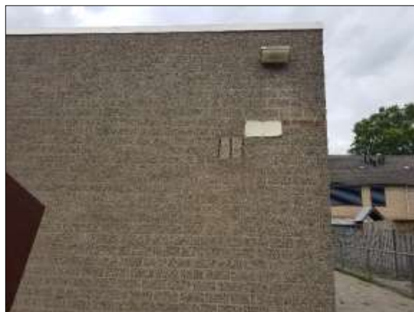
Figuur 9. Ventilatievoegen
