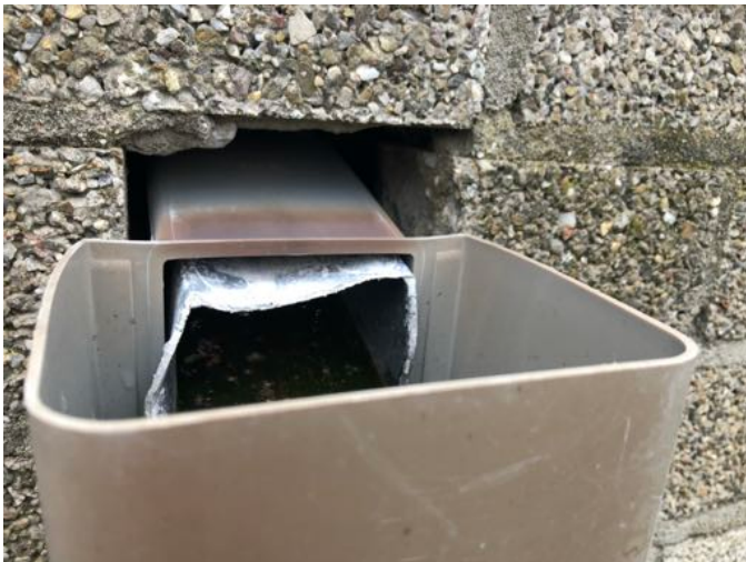
Links: Aansluiting HWA voor afsluiten. Rechts: Aansluiting HWA nadat borstels zijn geplaatst.
