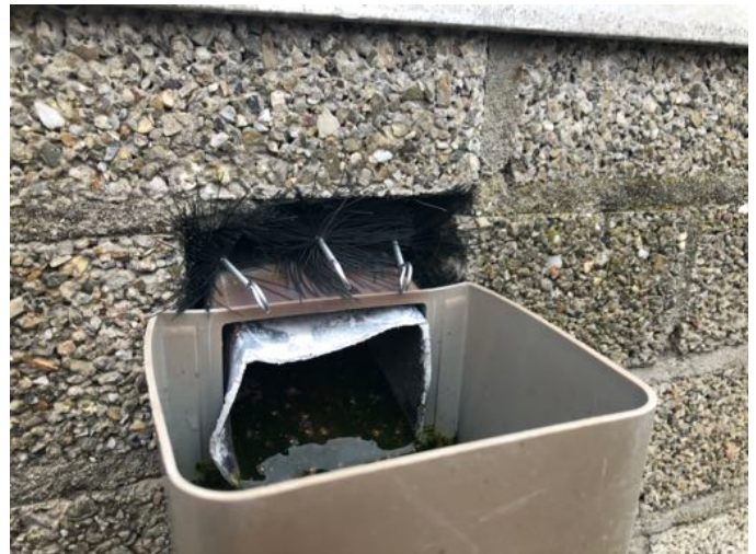
Links: Aansluiting HWA voor afsluiten. Rechts: Aansluiting HWA nadat borstels zijn geplaatst.
