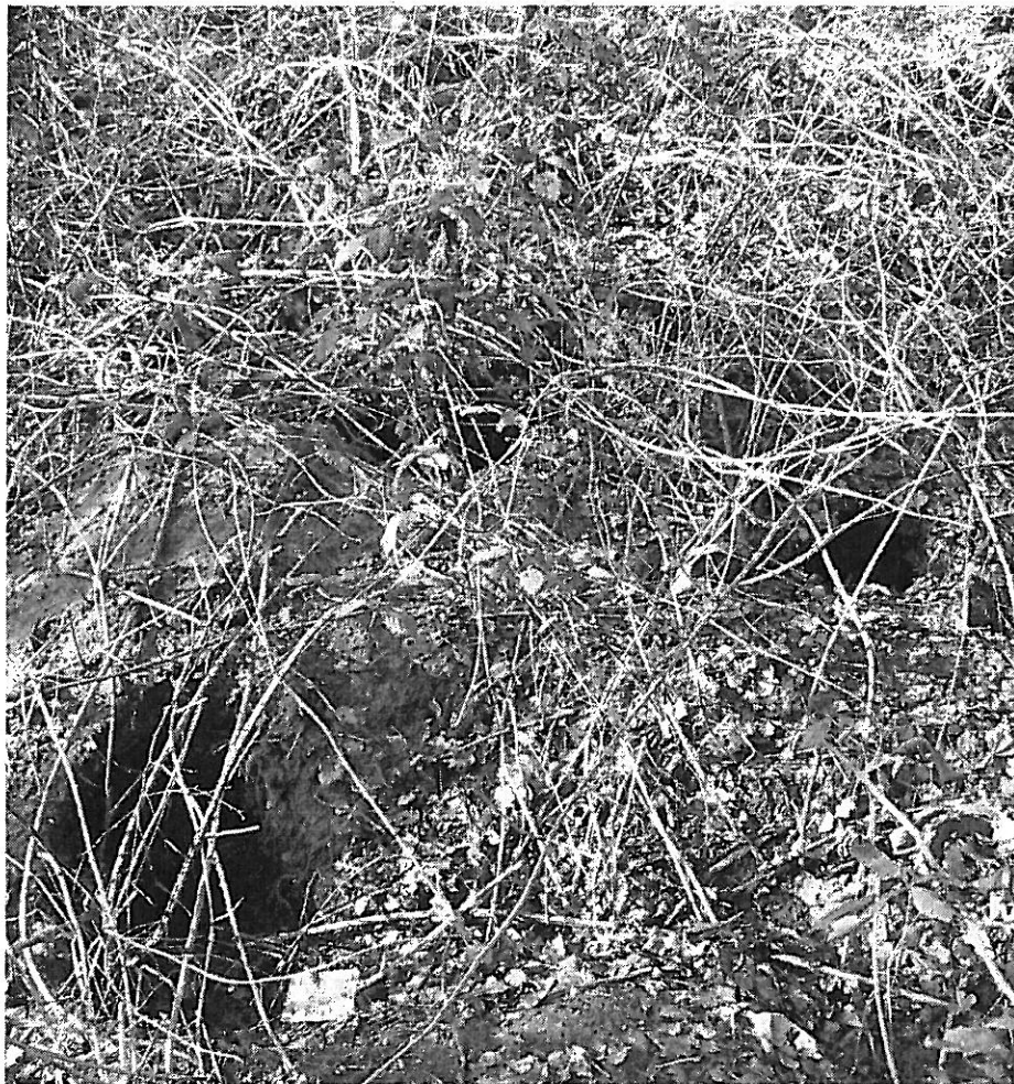
Foto 3 Konijnenholen in het talud van de Terraweg
