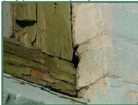
Opening bij raamkozijn bedrijfswoning
