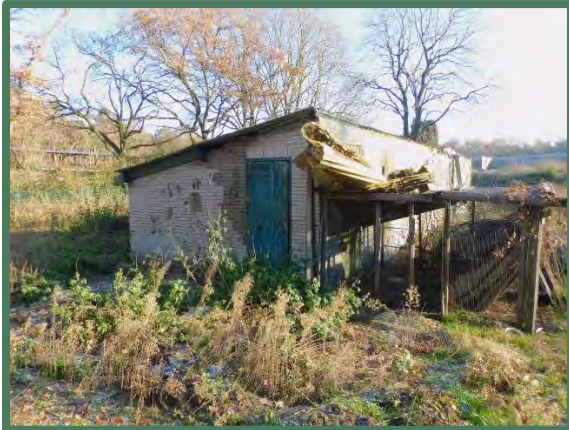
Overzicht zijde voormalige kippenschuur
