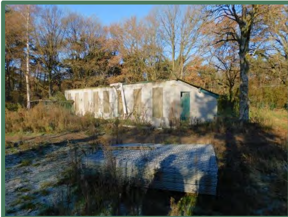
Overzicht voorzijde kippenschuur
