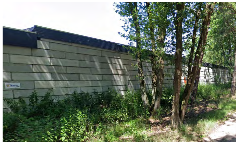
Blinde muur aan de Schietbaanlaan
