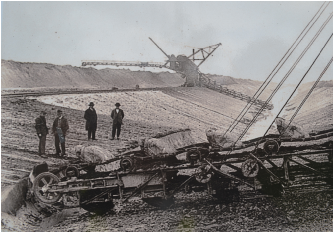
Afbeelding 10: Aanleg van het Wilhelminakanaal. Bron: Heemkundekring De Heerlijkheid Oirschot.
