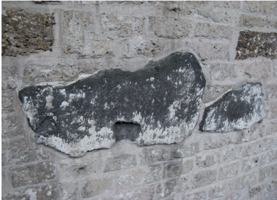
Afbeelding 5.42: Tufstenen muur van het 'Boterkerkje' te Oirschot met ingemetselde blokken basaltlava (donkergrijs) en moeras-ijzererts (bruin).
