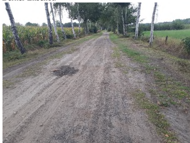
Fotonummer: 28 Omschrijving: HDD Baksebenweg, Berkel-Enschot.
