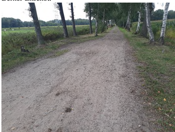
Fotonummer: 29 Omschrijving: HDD Hoevenseweg, Berkel-Enschot.
