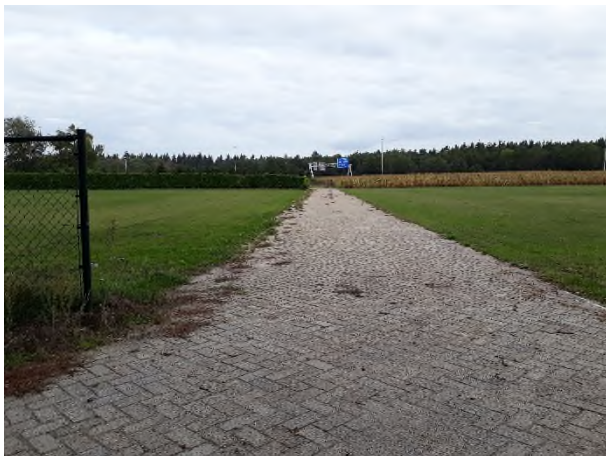
Fotonummer: 31 Omschrijving: HDD Tilburgseweg, Moergestel.
