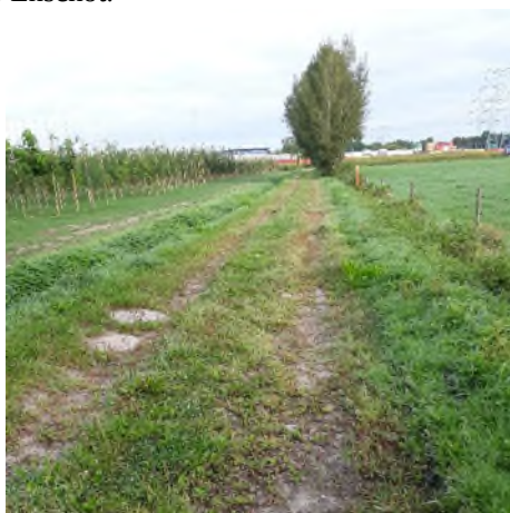
Fotonummer: 21 Omschrijving: Open ontgraving Enschootsebaan, Berkel-Enschoot.
