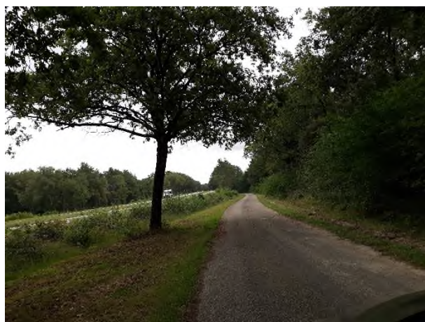
Fotonummer: 30 Omschrijving: HDD Tilburgseweg, Moergestel.
