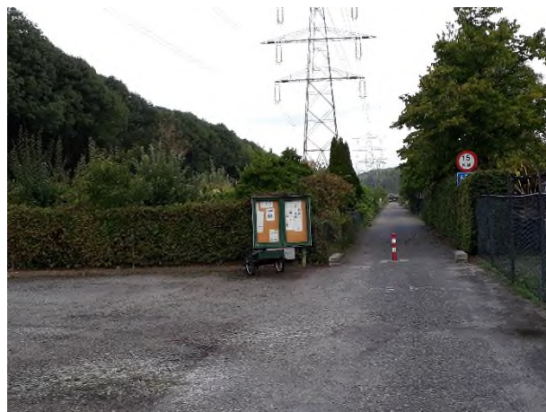
Fotonummer: 8 Omschrijving: HDD Volkstuin (Hazennest-west, Tilburg).
