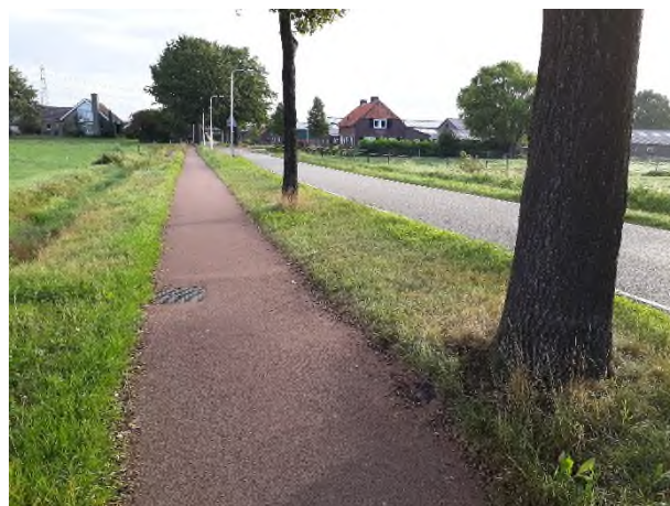
Fotonummer: 20 Omschrijving: HDD Enschootsebaan, Berkel-Enschoot.
