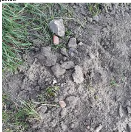
Fotonummer: 36 Omschrijving: Open ontgraving Sebrechtsedijk, Moergestel.
