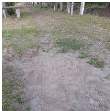
Fotonummer: 38 Omschrijving: HDD Kerkeindse Heide, Moergestel (DKM06).
