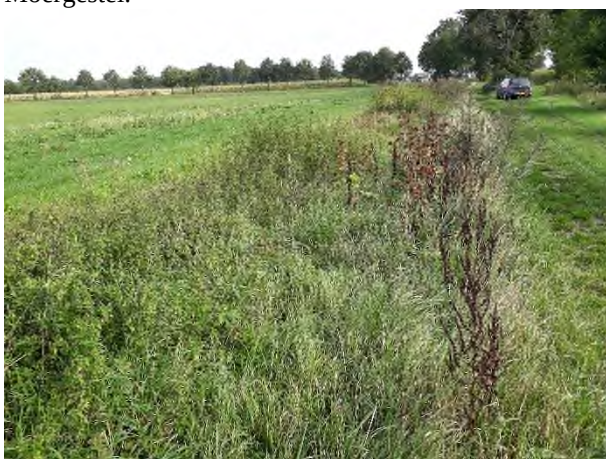
Fotonummer: 35 Omschrijving: Open ontgraving Sebrechtsedijk, Moergestel.
