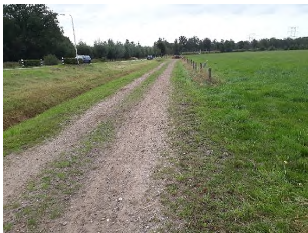
Fotonummer: 27 Omschrijving: Open ontgraving Baksevenweg 1, Berkel-Enschot.
