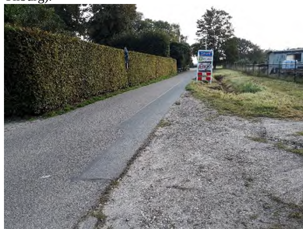
Fotonummer: 10 Omschrijving: : HDD Volkstuin (Hazennest-west, Tilburg).
