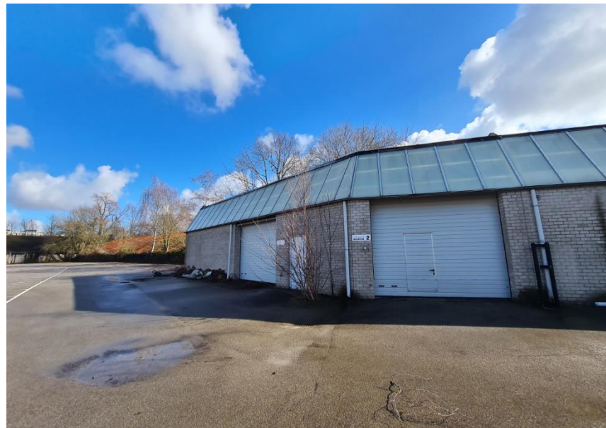
Figuur 5: Bebouwing in het zuidoosten van het plangebied
