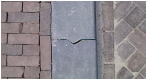
Rijbaan in klinkers, hardsteenkleurige trottoirbanden Trottoir gestraat met dezelfde klinkers
