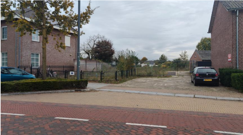
Figuur 2.3 Weergave projectgebied vanaf de Nieuwstraat na sloop
