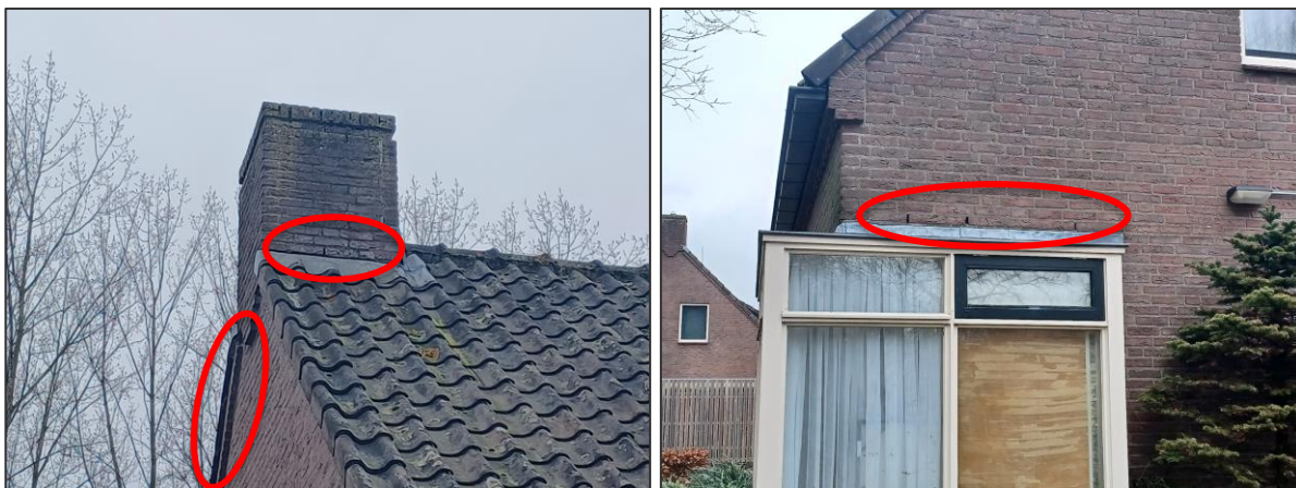
Figuur 3.1: Geschikte invliegopeningen voor vleermuizen bij de 2 woningen (met rood aangegeven).
