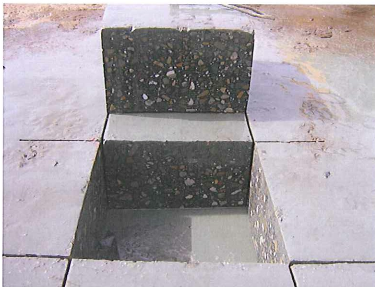
Foto 5: verwijderen beton ten behoeve van het graven van inspectiegaten (asbestonderzoek)
