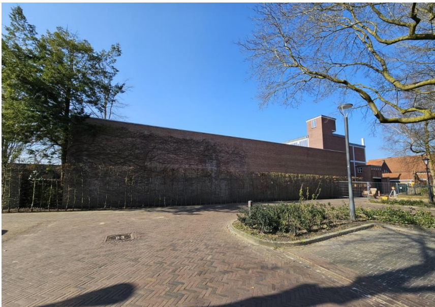
Figuur 5: Gevel bebouwing bij parkeerplaats Achter de Kerk
