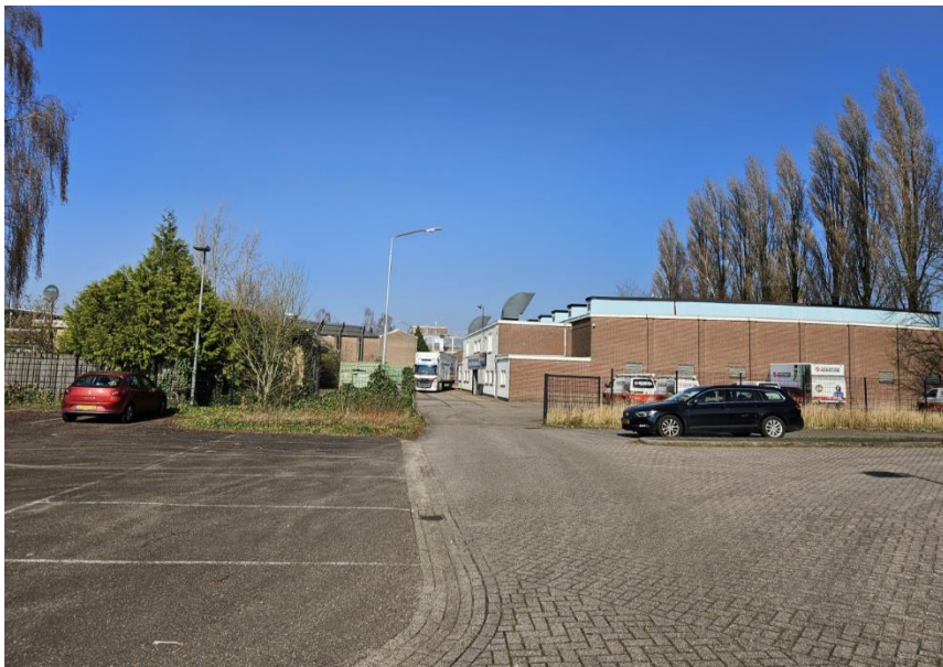
Figuur 4: Ingang terrein zuidzijde
