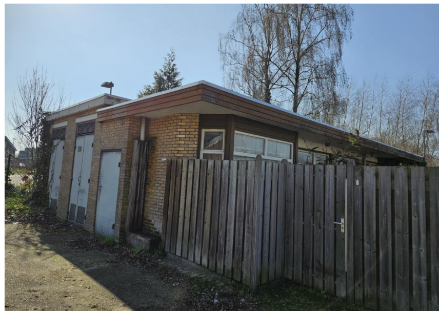
Figuur 11: Bebouwing en trafo in zuiden terrein
