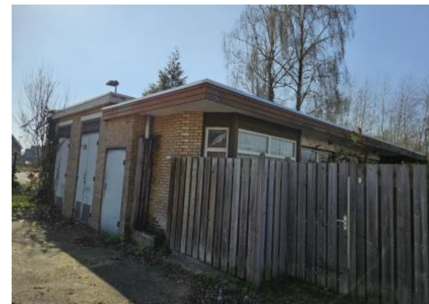
Figuur 8: Bebouwing en trafo in zuiden terrein
