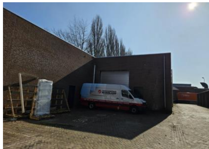
Figuur 7: Bebouwing aan Oostzijde
