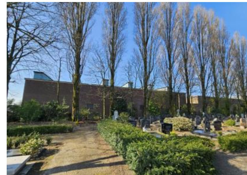
Figuur 5: Gevels gezien vanaf begraafplaats St. Odulphus
