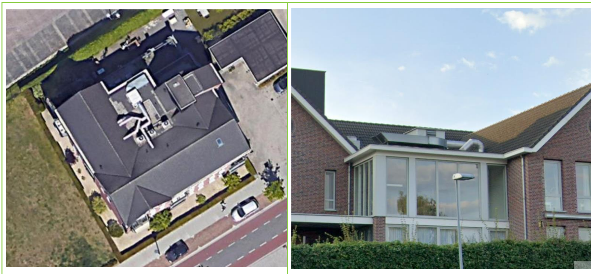
Figuur 1. Boveraanzicht (links) en achteraanzicht (rechts) installaties Molenhuis (bron: Google).
