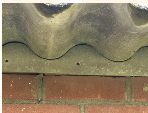
2f. Afwerking dakplaten gebouw C
