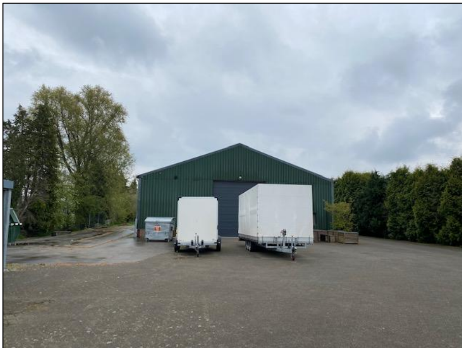
Figuur 4: Huidige situatie plangebied: zicht op achterzijde opslagloods
