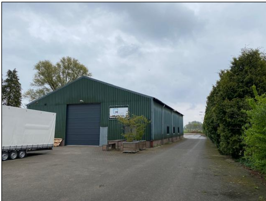
Figuur 6: Huidige situatie plangebied: zicht op voorzijde opslagloods (2)
