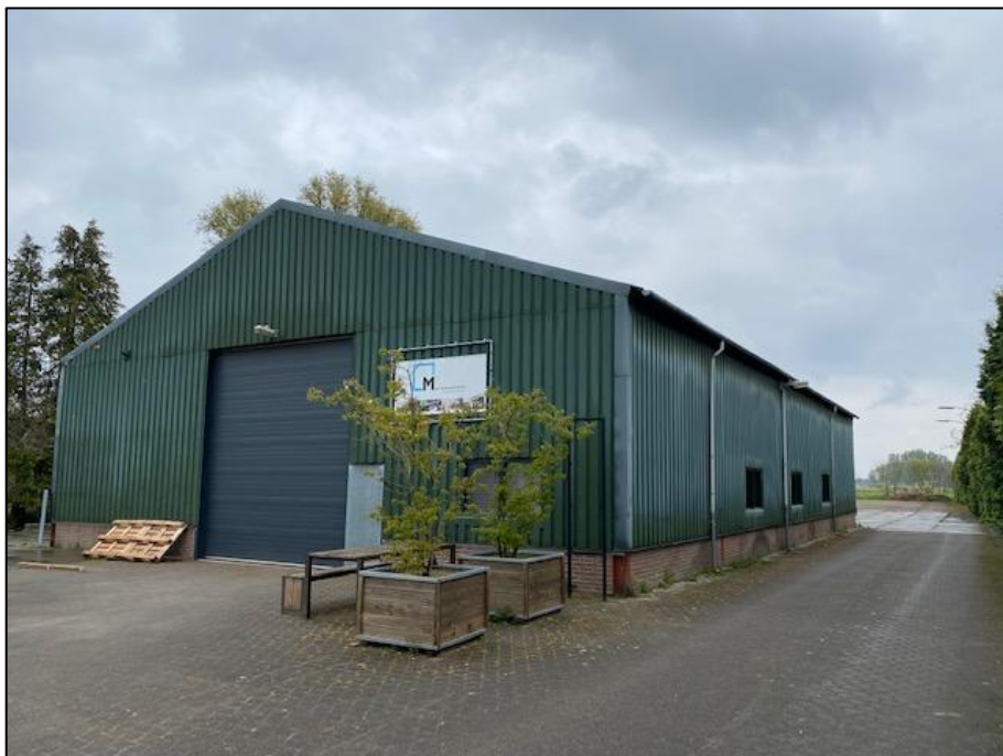
Figuur 5: Huidige situatie plangebied: zicht op voorzijde opslagloods (1)
