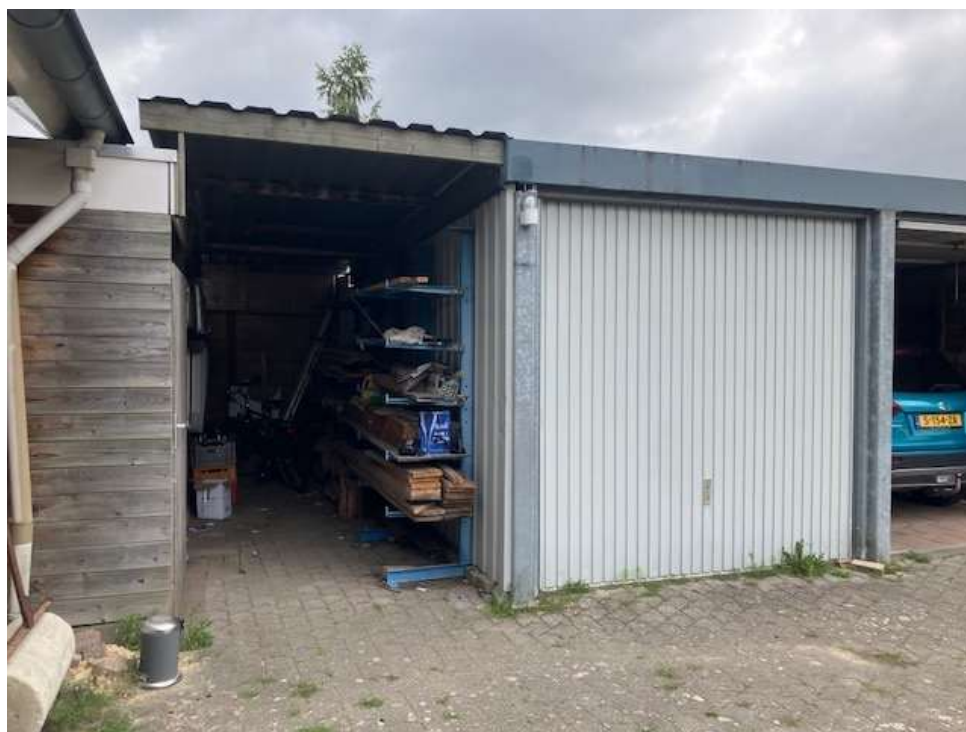
• Afbeelding 4: Te slopen garage achter het woonhuis
