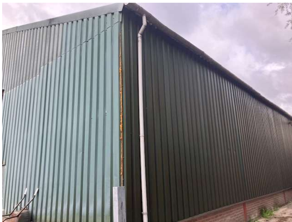
• Afbeelding 13: Openingen dicht gepurd
