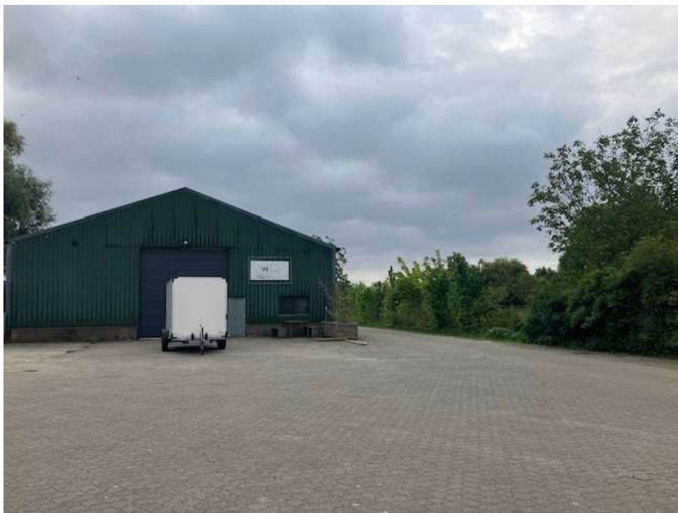
• Afbeelding 6: Te verwijderen erfverharding en te slopen loods
