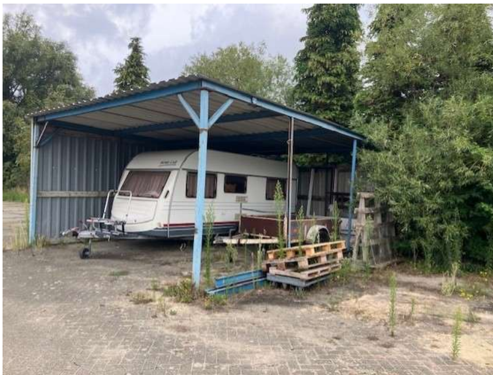
• Afbeelding 11: Te slopen overkapping
