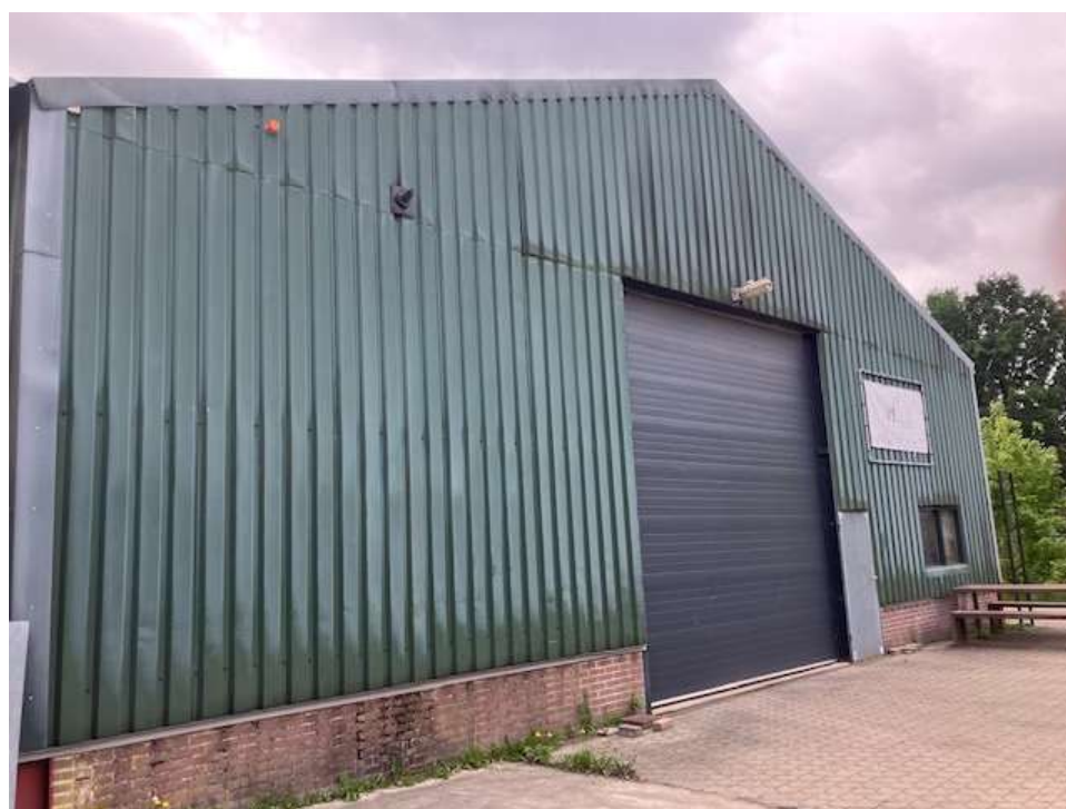
• Afbeelding 14: Vooraanzicht te slopen loods
