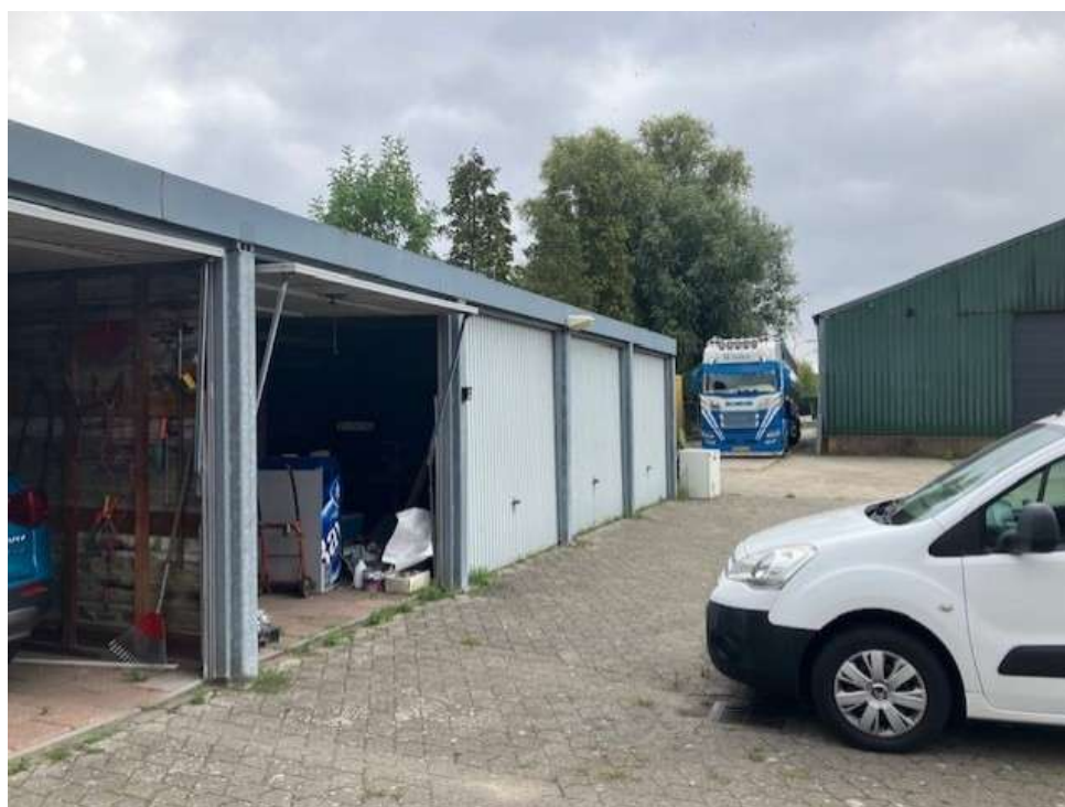
• Afbeelding 5: Zijaanzicht te slopen garage
