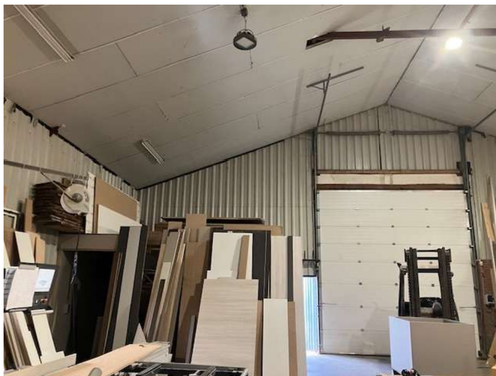
• Afbeelding 17: Plafond binnenzijde te slopen loods
