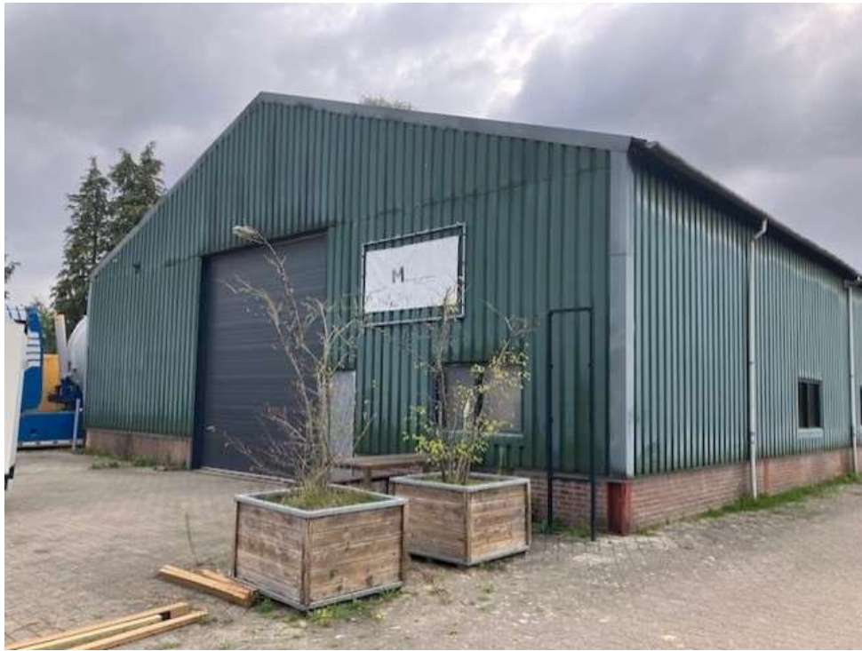
• Afbeelding 8: Vooraanzicht te slopen loods
