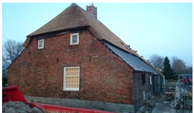
Foto: realisatie van twee woningen in een monumentale boerderij aan de Burgstraat
